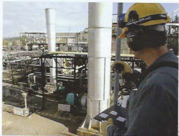
Un rondiste à Lacq contrôle le bon fonctionnement des installations.
