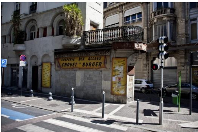
Certains locaux ont été murés pour éviter les squatteurs
