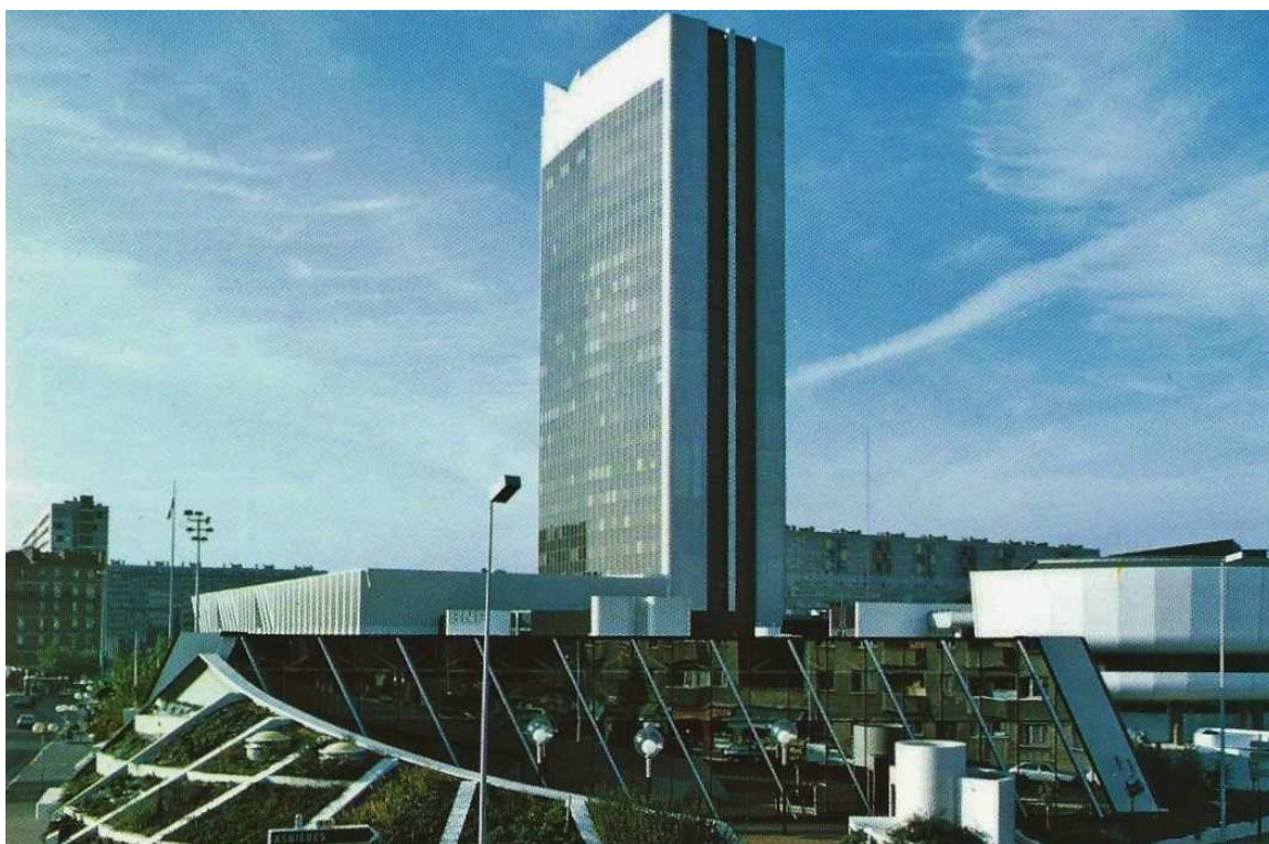
La tour de la Mairie du Centre Administratif Commercial et Culturel de Gennevilliers inauguré en 1978 (collection privé, J.N)
